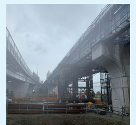
足場組立工事
