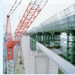
橋梁工事 香川県番の州高架橋
