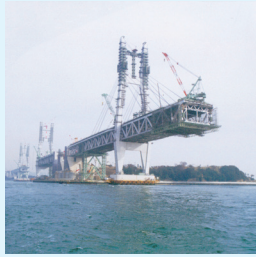
橋梁工事 香川県岩黒島橋
