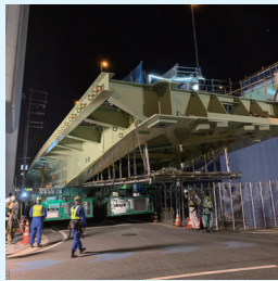
橋梁工事 西船場JCT
