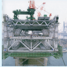
橋梁工事 香川県与島橋
