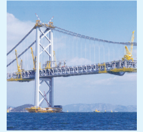
橋梁工事 香川県南備讃瀬戸大橋
