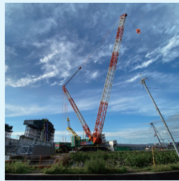
橋梁工事 城陽第二高架橋
